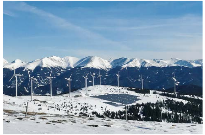
Abb. 3. Wind- und PV-Park in Lachtal, Österreich. Manchmal steigt die Akzeptanz von Windkraft, wenn sie mit PV-Anlagen kombiniert wird.
