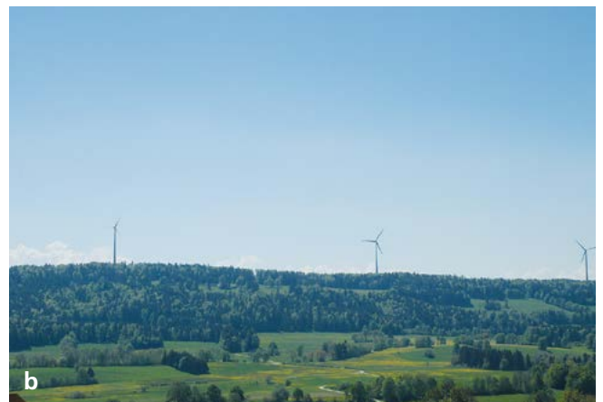
Abb. 5. a) Der Windpark Gütsch befindet sich in einer alpinen Umgebung. b) Die drei Anlagen des Windparks La Peuchapatte im Jura.
